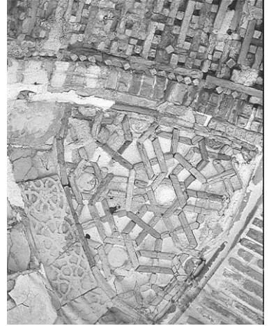
Resim 28; Mogaki Attari Camii Güney Taç Kapı Kavsarası (Çeşmeli)
