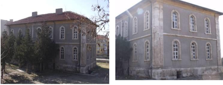
Fot.3. Koçhisar redif deposu binası, giriş ve yan cephe.
