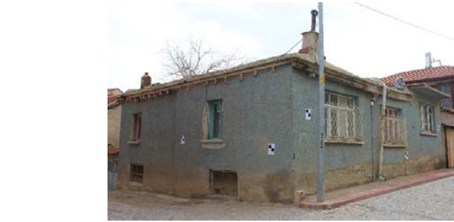
Şekil 11. Geleneksel Akşehir evlerinde toprak dam uygulaması (Kocataş, 2011, s:52; Yazalara ait fotoğraf arşivi, 2020).
