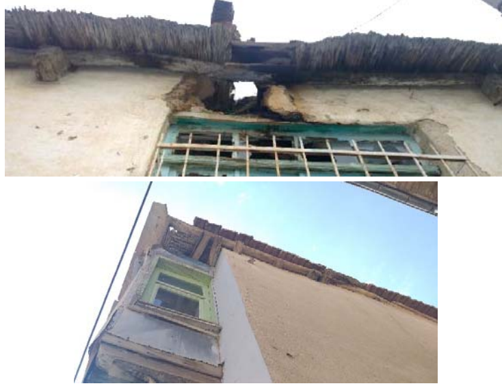
Şekil 12. Geleneksel Akşehir evlerinde çatıdan kamış (üstte) ve kamış üstü kiremit (altta) uzatılmasıyla saçak oluşturulması (Duran, 2016, s:29; Yazarlara ait fotoğraf arşivi, 2020).
