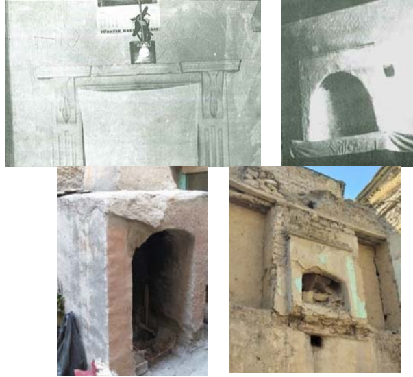
Şekil 7. Müşerref Hanım evinde alçı yaşmaklı ocak (üstte-solda), Hafız Arif evinde ocak (üstte-sağda) ve Akşehir evlerinde avluda ocak kulanımı (altta) (Gençer, 1995, s: 10; Yazarlara ait fotoğraf arşivi, 2020).
