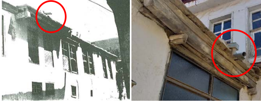
Şekil 10. Geleneksel Akşehir evleri ve çatıdan sarkıtılan ahşap (solda) ve çinko (sağda) oluk detayı (yuvarlak hat içinde gösterilmiştir) (Gençer, 1995, s: 5; Yazalara ait fotoğraf arşivi, 2020).
