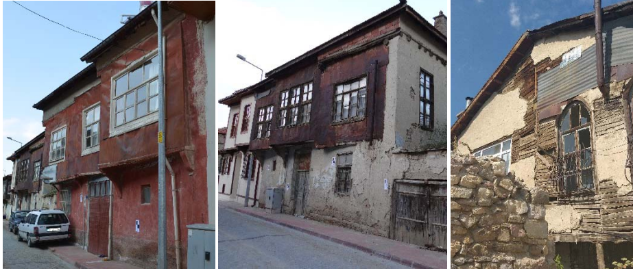
Şekil 17. Cephelerde sac kaplama ve bağdadi çita uygulaması (Yazarlara ait fotoğraf arşivi, 2020)
