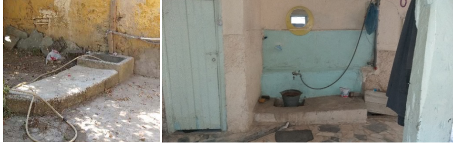
Şekil 16. Geleneksel Akşehir evlerinde avluda çeşme kullanımı (Yazarlara ait fotoğraf arşivi, 2020).
