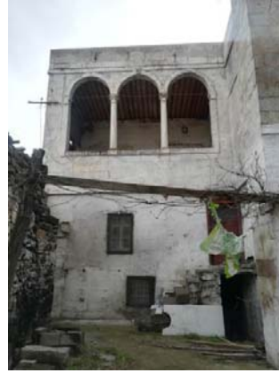
Fot. 11. Kuzeybatı cephesindeki köşk açıklığı, selamlık ve bodrum kat giriş kapısı.
