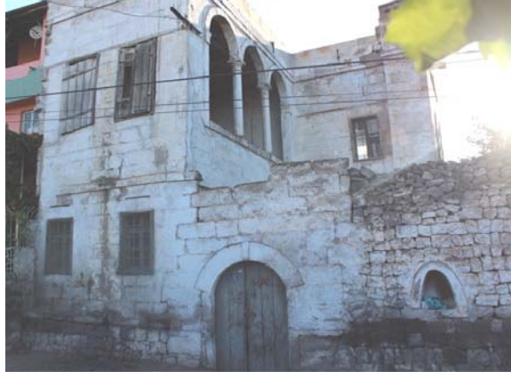
Fot. 8. Kuzeydoğu Cephesi.
