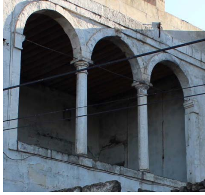
Fot. 12. Kuzeybatı cephesindeki köşk açıklığı.
