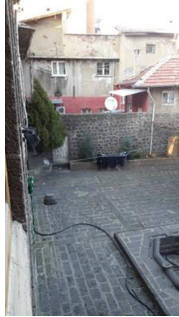
Fot. 21. Konağın kuzey yönündeki ek avlusuna orta avludan bakış (Çalın, 2015).
