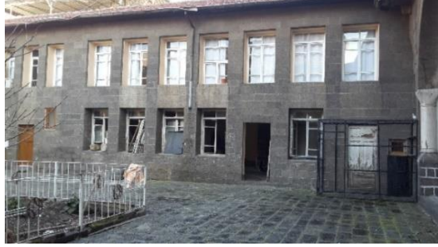
Fot. 16. Konağın doğu cephesinden görünüm (Çalın, 2015).
