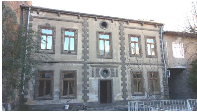
Fot. 12. Konağın batı kanadı cephesi (Çalın, 2015)
