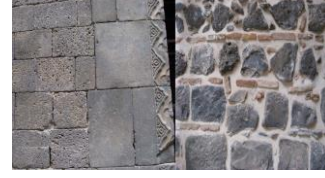
Bazalt taş ve tuğla karışımı dış cephe yığma taş duvar 15
