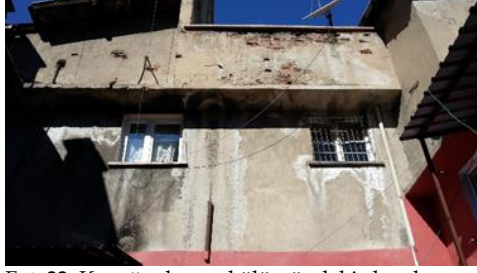
Fot. 22. Konağın kuzey bölümündeki ek avlusu (Çalın, 2015).
