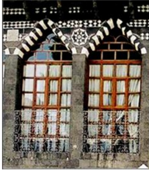
Geleneksel Diyarbakır evlerinde dilimli pencere ve taş yüzeylerdeki cas sıva ile yapılmış bezemeler 16 .
