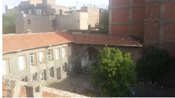
Fot. 18. Konağın orta avlusunun üst görünümü (Çalın, 2015).
