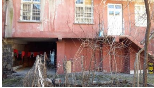
Fot. 20. Konağın doğu bölümündeki ek avlusunun orta avluya bakan cephesi (Çalın, 2015).
