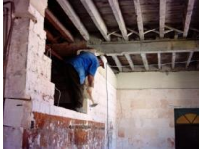
Fot. 10. Gözlem Odası restorasyon çalışmalarından bir görünüş (Uğraş, 2003).
