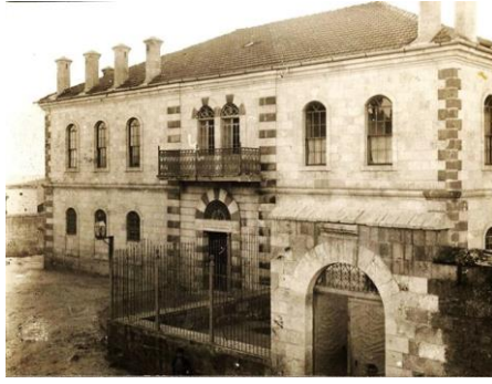
Fot. 7. Acil binasının 1910-1915 yıllarındaki görünüşü (Uzun, T. arşivi).
