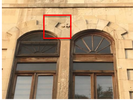
Fot. 22. B blok güney cephesindeki taşa işlenmiş arma (Uğraş, 2018).
