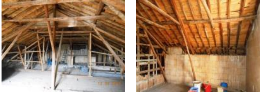
Fot. 28. B Blok çatı içi (Uğraş, 2013).
