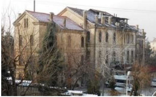
Fot. 23. B Blok çatı ve bacalarını gösteren görünüş (Uzun, T. arşivi)
