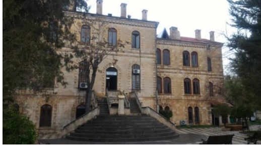
Fot. 21. B Blok güney cephesindeki giriş (Aygün, 2018).
