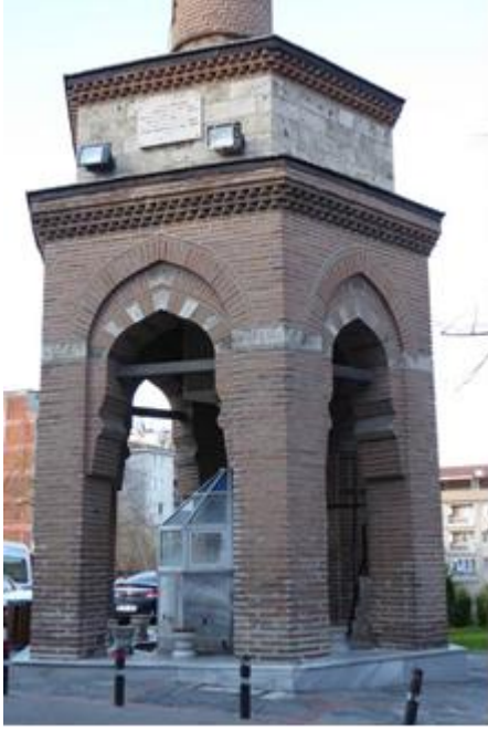
Fot. 4: Bursa Timurtaş Paşa Camii'nin minare şadırvanı (Melda Ermiş, 2015).
