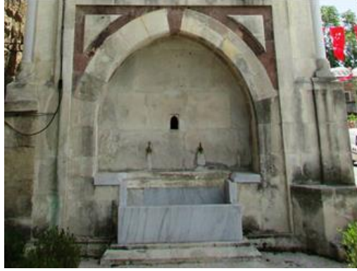
Fot. 8. Edirne Eski Camii kuzeybatı minare kaidesindeki çeşme (2017).
