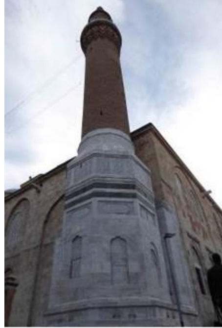
Fot. 5: Bursa Ulu Camii'nin kuzeybatı minare ve çeşmesi (Melda Ermiş, 2015).
