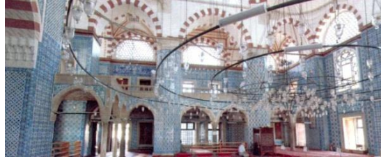
Fot.16. Doğu cephesi duvarı (Kutlu, 2012).
