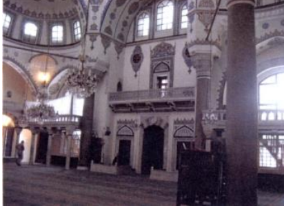
Fot.13. Kuzey duvarı görünüşü (Kutlu, 2012).
