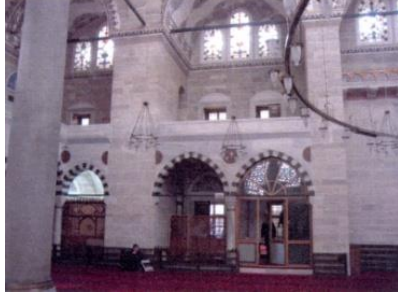
Fot.11. Kuzey duvarı görünüşü (Kutlu, 2012).
