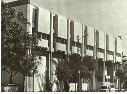
Resim 3.15. Merkez Bankası ön cephesi (Mimarlık s.76)
