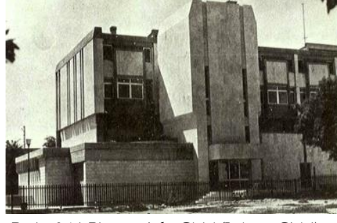
Resim 3.16. Binanın Arka Girişi (Lojman Girişi) (Koyunoğlu Müzesi, Fotoğraf Arşivi)
