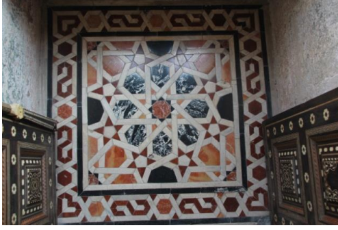
Resim 22. Selimiye Camii hünkâr mahfili zemin döşeme.
