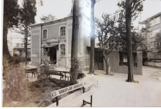
Fot. 14.Hamidiye Camii ve ek bina (İstanbul 5 nolu Kültür ve Tabiat Varlıklarını Koruma Kurulu Arşivi 1985)
