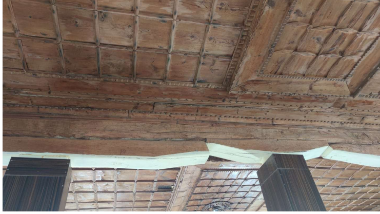
Fot. 3. Eski Akin Köy Camii Harim, Ayaklara Oturan Yatay Ahşap Kirişler ve Ahşap Tavan
