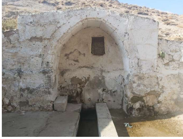
Fot. 6. Eski Akin Köy Çeşmesi Ana Cephe Görünüş
