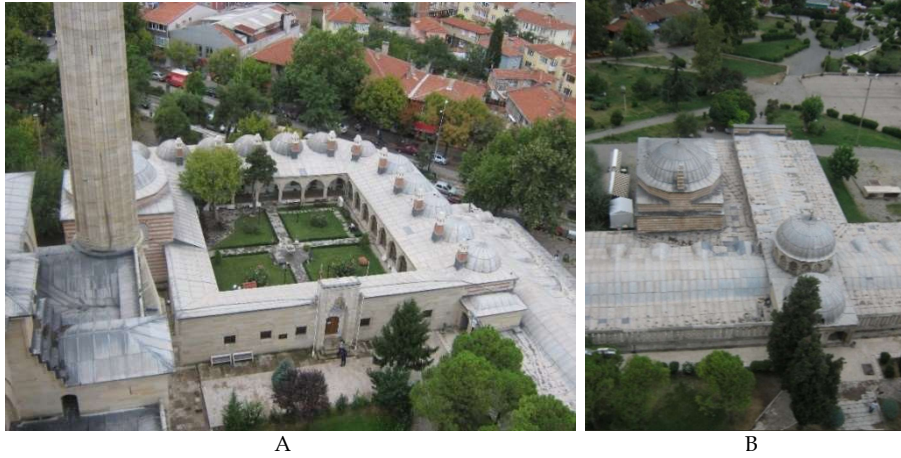
Şekil 4. A. Darul Kurra Medresesi üstten görünüş, B. Arasta ile sıbyan mektebinin üstten görünüşü (Kaynak: Yazarlara ait fotoğraf arşivi, 2011)
