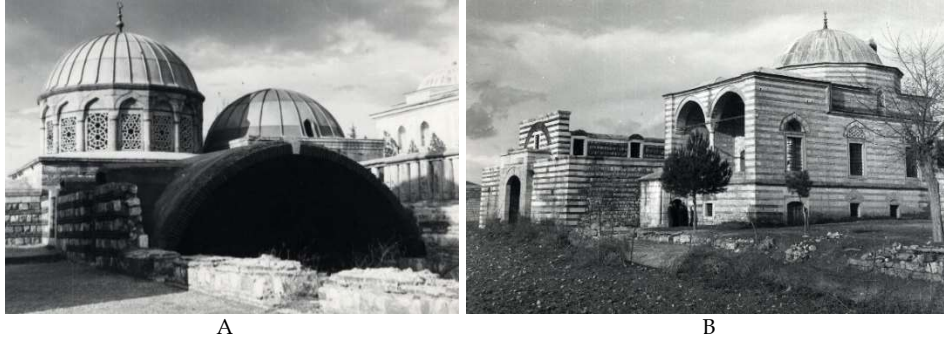
Şekil 17. A. Arastanın orta kubbesinin tamburundaki alçı şebekeli açıklıklar B. Sıbyan Mektebi orta sıra pencerelerinde aynalarda alçı dışlıklar (Kaynak: Vakıflar Genel Müdürlüğü Arşivi).
