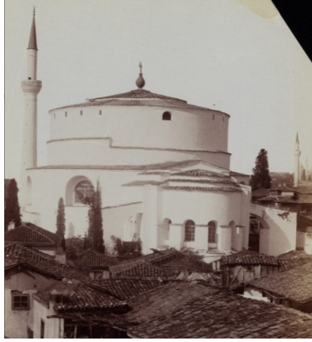
Şekil 9. Yapılan eklemelerin dışarıdan görünümü (Web-3).
