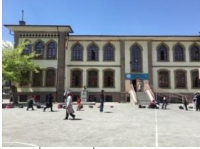
Resim 33. İsmet Paşa İlkokulu Doğu Cephesi
