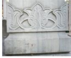
Fot. 15. Yan cephe taç bölümü.
