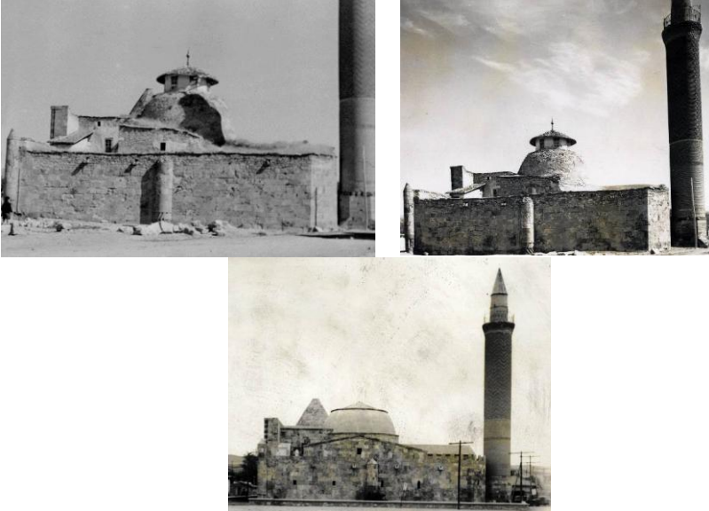
Şekil 11. Cacabey Medresesi'nin 1940'lı yıllarda gerçekleştirilen damının temizlenmeden önceki (Sol üst) ve sonrasındaki (sağ üst) fotoğrafları Vakıflar Genel Müdürlüğü arşivinde yer almaktadır. 1960'larda süren restorasyonlar sonrası çekilen fotoğrafından (alt), medresenin beden duvarlarında büyük oranda değişim yapıldığı ve üst örtü sisteminin değiştirildiği görülmektedir.
