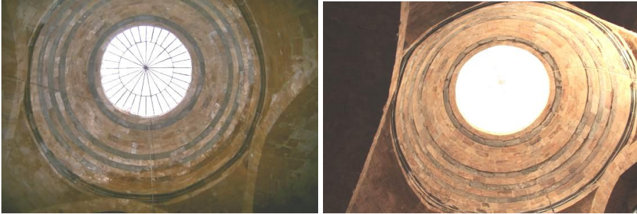
Fot. 4. Kubbenin 1960 onarımında piramidal (VGM Arşivi, 2011) ve 2008 onarımı sonrasında ise küre parçası şeklinde olan metal konstrüksiyonlu cam yüzeylerle kapatılmıştır.
