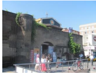
Fot. 4. Medresenin yanında yer alan yapı ve Sahabiye Çeşmesi
