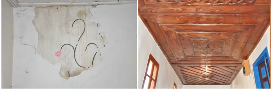
Fot. 8. Mahfil üstte sıva dökülen bölümde kalemişi ve ek mahfil tavanı (Karakuş, 2019)
