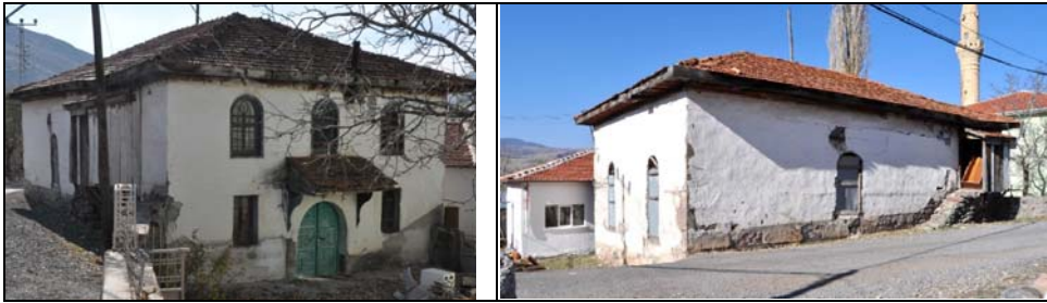
Fot. 13. Çukurören Köyü Camii kuzeydoğu ve güneydoğu görünüş (Karakuş, 2018)
