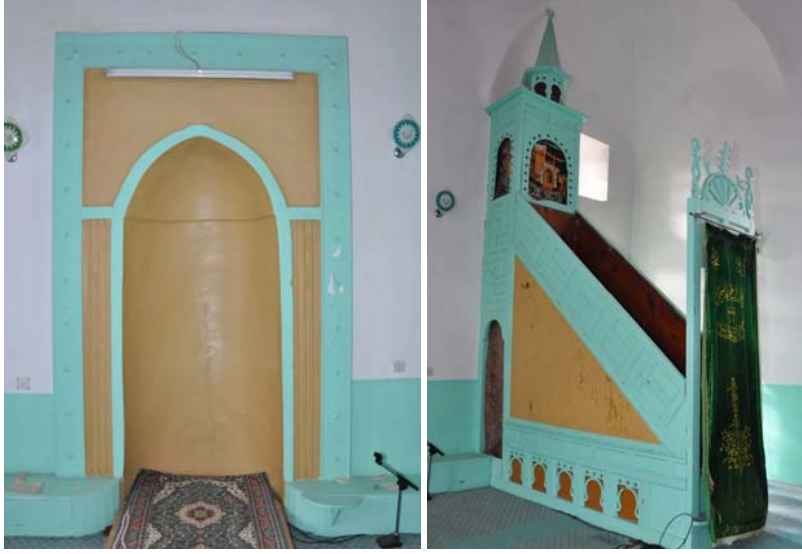
Fot. 10. Onarım öncesi mihrap ve minber (Karakuş, 2016)
