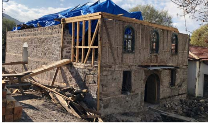
Fot. 14. Yığma moloz taş duvar ve son cemaat ahşap karkas sistem (Karakuş, 2019)
