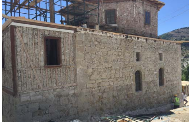
Fot. 4.. Yığma moloz taş sistem ve son cemaate ahşap karkas sistem (Karakuş, 2019)
