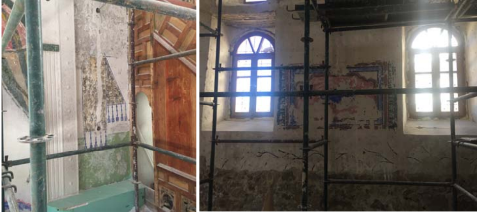
Fot. 9. Raspa sonrası ortaya çıkan kalemişleri (Karakuş, 2019)
