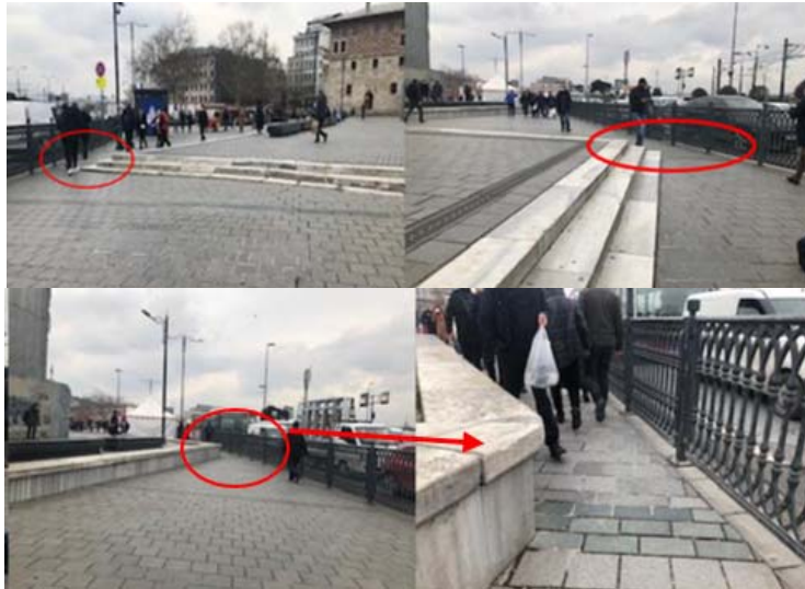
Fot. 4. Eminönü Meydanı'nda Mısır Çarşısı yönüne rahat geçiş bakımından sorun oluşturan detaylar
