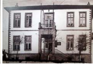
Fot. 3.5. Halkevi Binası Ön Cephe
