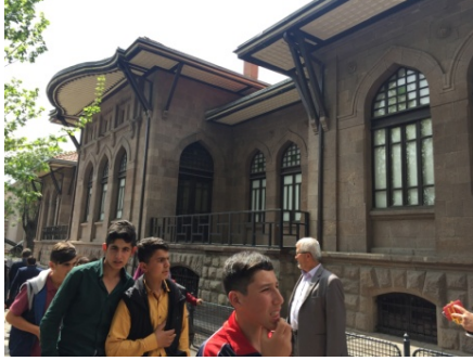
Fot. 2.5. I. TBMM Binası (Yazar arşivi)
