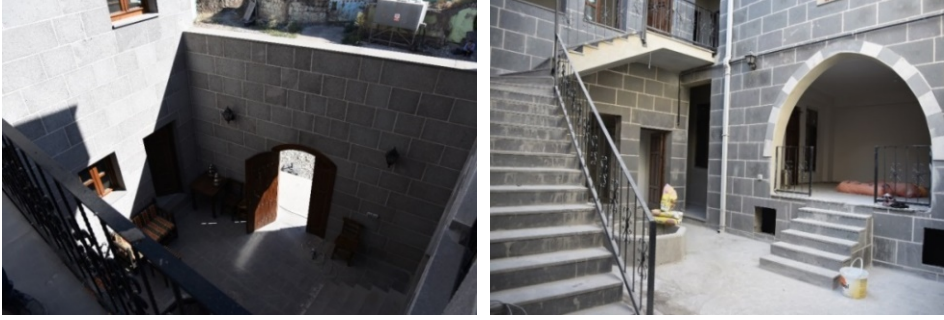
Fot. 11-12. Suriçi'nde çatışmalar sonrası yapılan evlerde iç avlu: Yersel aidiyetin yitimi ve yeniden inşa edilen geleneksel Diyarbakır evleri (Kerim Çınar, 2019)
