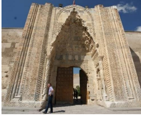
Fot. 3. Aksaray Sultan Hanı avlu taş kapısı.
