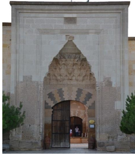
Fot. 2. Avanos Sarıhan avlu taç kapısı.
