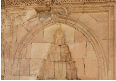
Fot. 9. Divriği Ulu Camii doğu taç kapısı kavsara kemeri taşlarının dizilişi.
